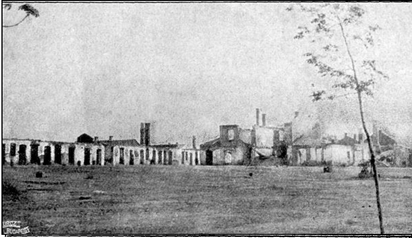
Egy 42 cm-es lövedék hatása a tarnovi vasúti épületek között.
