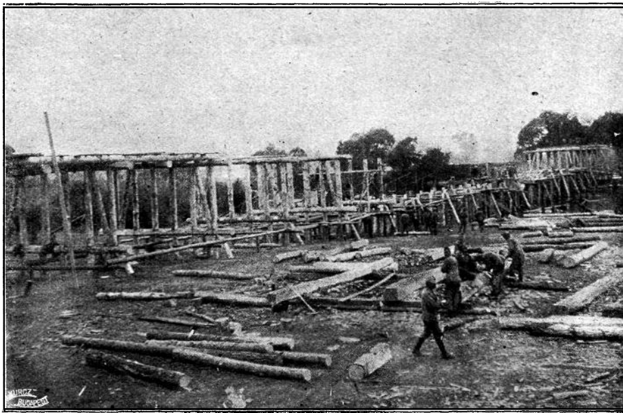
Utászaink helyreállítják a felrobbantott Wjeprz-hidat.
