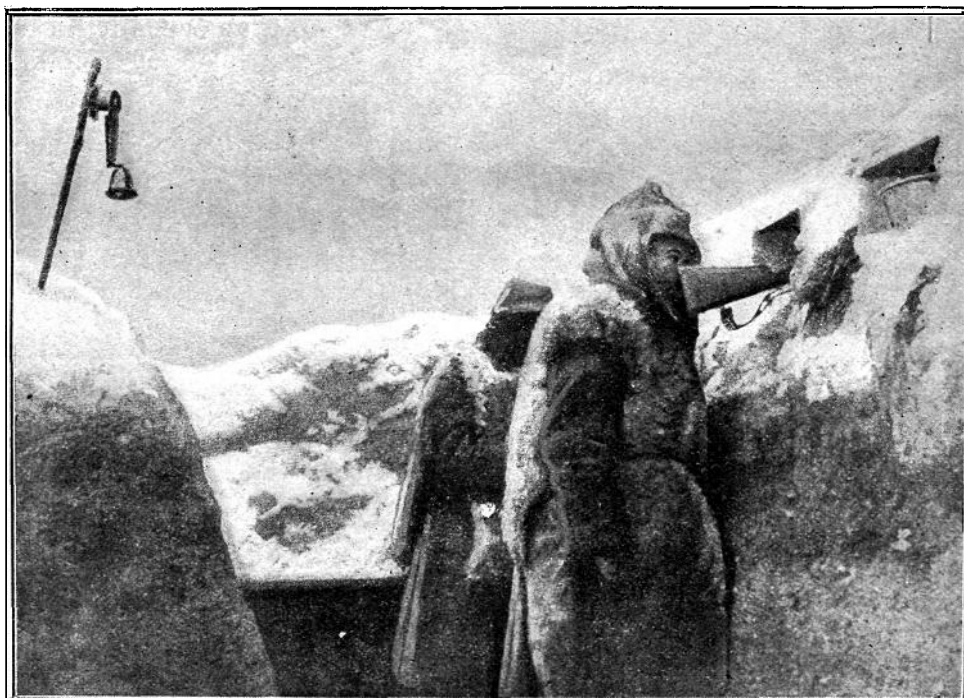
Riasztó csengő, amely éjjeli támadásoknál jelzi a drótsövénnyel érintett ellenséget.
